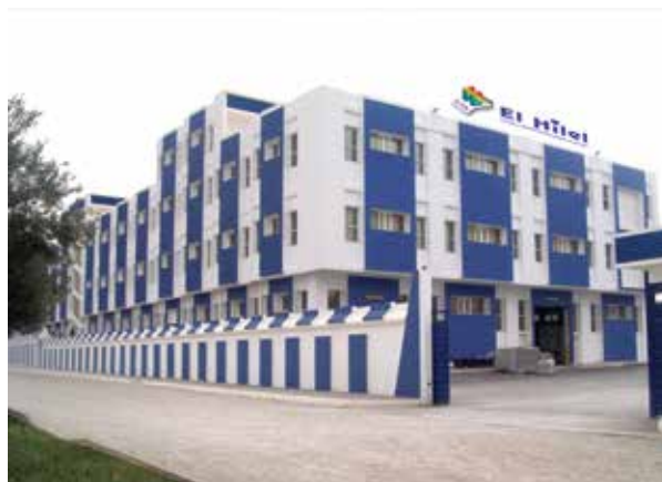
Les bâtiments d'imprimerie El Hilel
